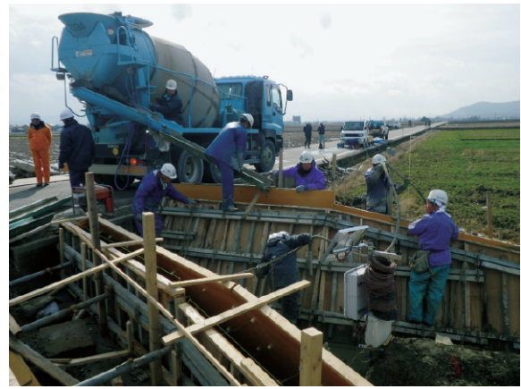
写真-1 試験施工の状況
