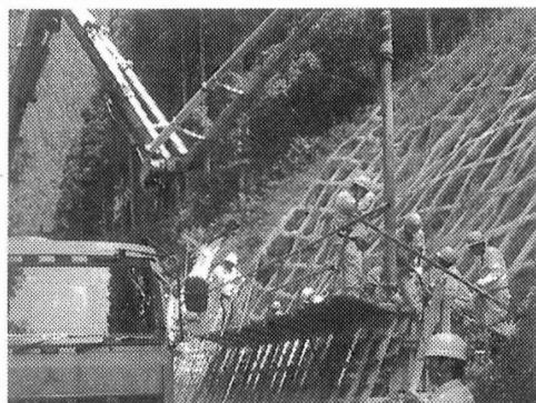
福井宇部FBコンの打設状況
