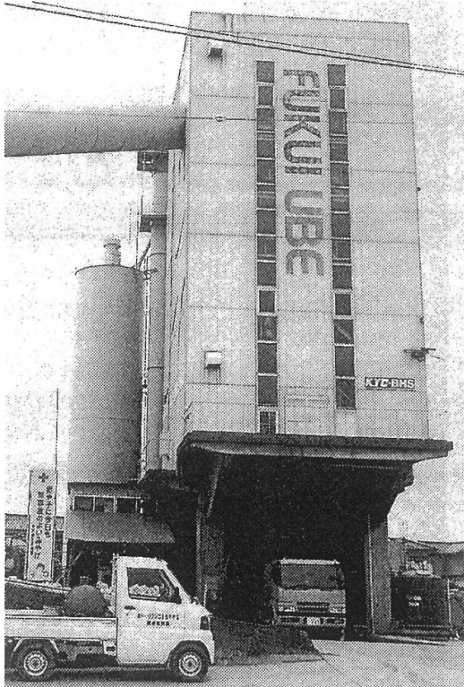
実機試験：高強度コンクリートの積込み状況
