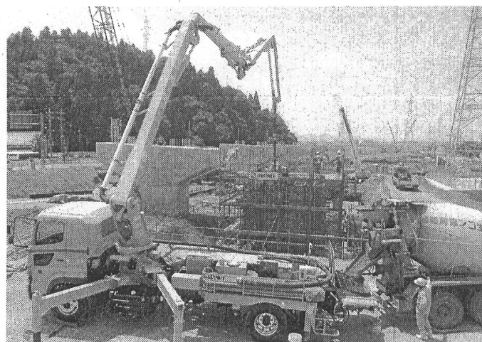
国交省の物件でFBコンの打設工事が進む
